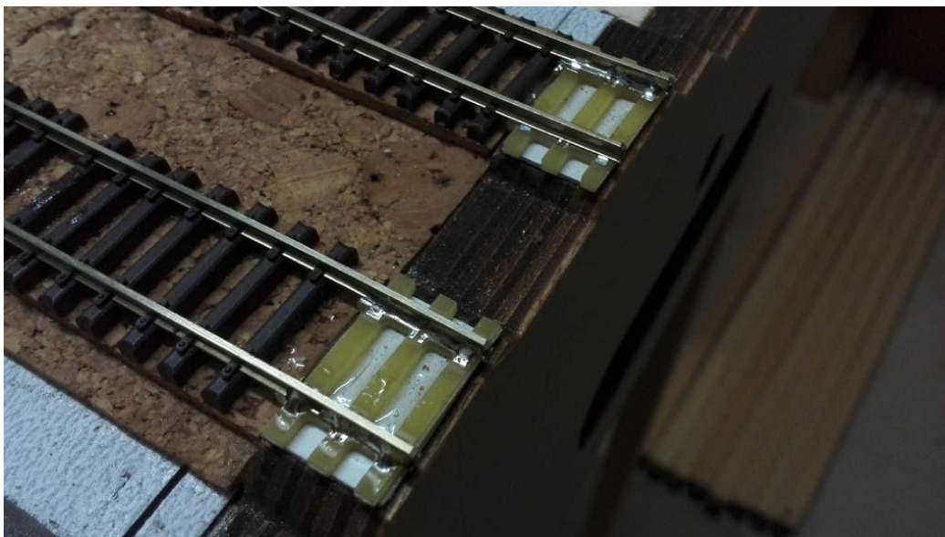
Posa e fissaggio delle solette sulla testata a Norma GasTT
